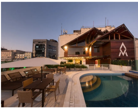
O Casa Mauá Residencial, projeto do Opportunity Imobiliário no Reviver Centro 2 — Foto: Divulgação
